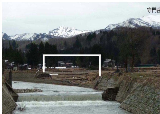
図7 塩谷川の見られる堤防 (図4の④地点)
