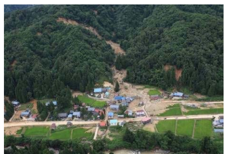
牛野尾地区の土石流被害 県の HP より
