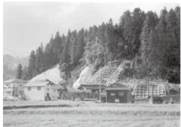
写真 2 中越地震で頻発した裏山の崩壊に対し、法枠工が施工されている例が多い（小千谷市）
