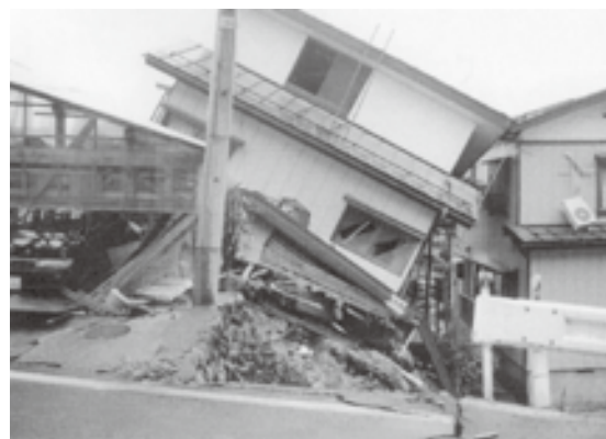
写真5 道路面に合わせて盛土した上に建設された住宅。隣家に寄りかかった状態で静止した。
