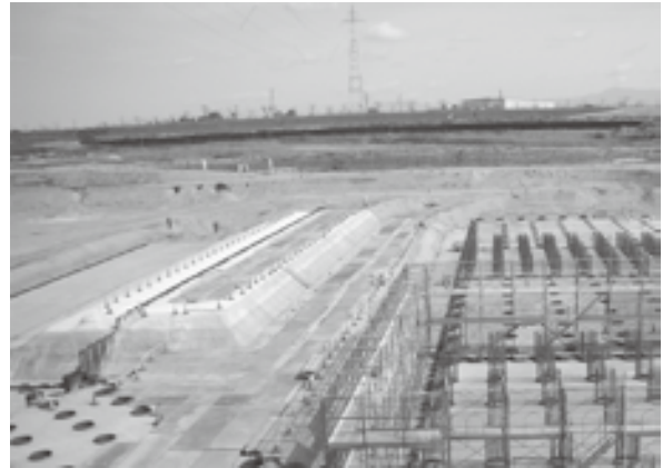
写真5 新可動堰の基礎工事
