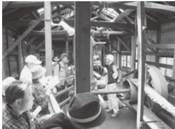
写真7 ポンピングパワー(1)
