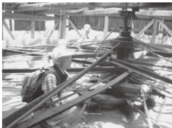
写真8 ポンピングパワー(2)
