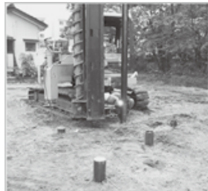
図 5 鋼管杭回転圧入工法
