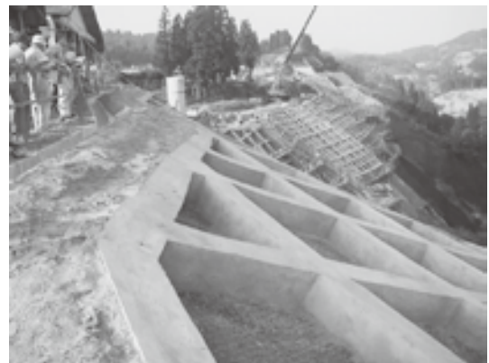
図12 榎ノ木地すべり工事
