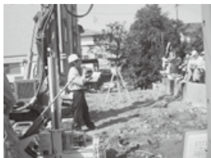
図1 工事現場の巡検の様子
