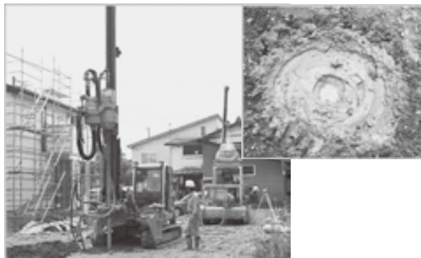
図 4 深層混合処理工法（セメントコラム）
