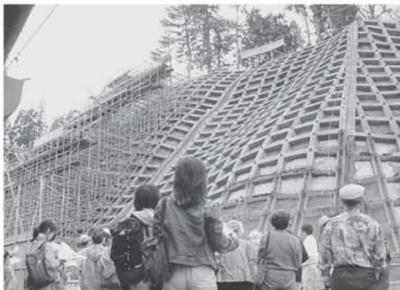
西谷寺尾地区の傾斜地崩壊対策工事
