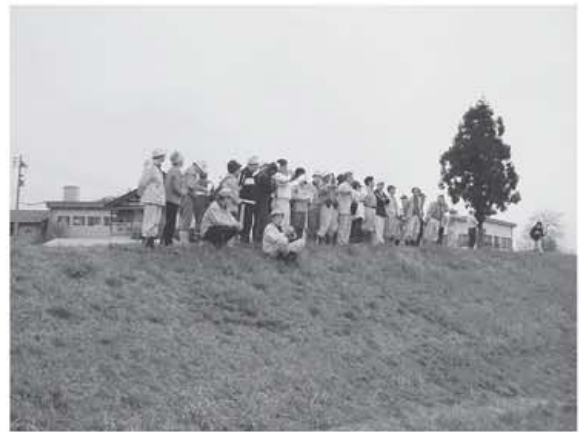
妙見崩落現場復旧工事を対岸から観察
