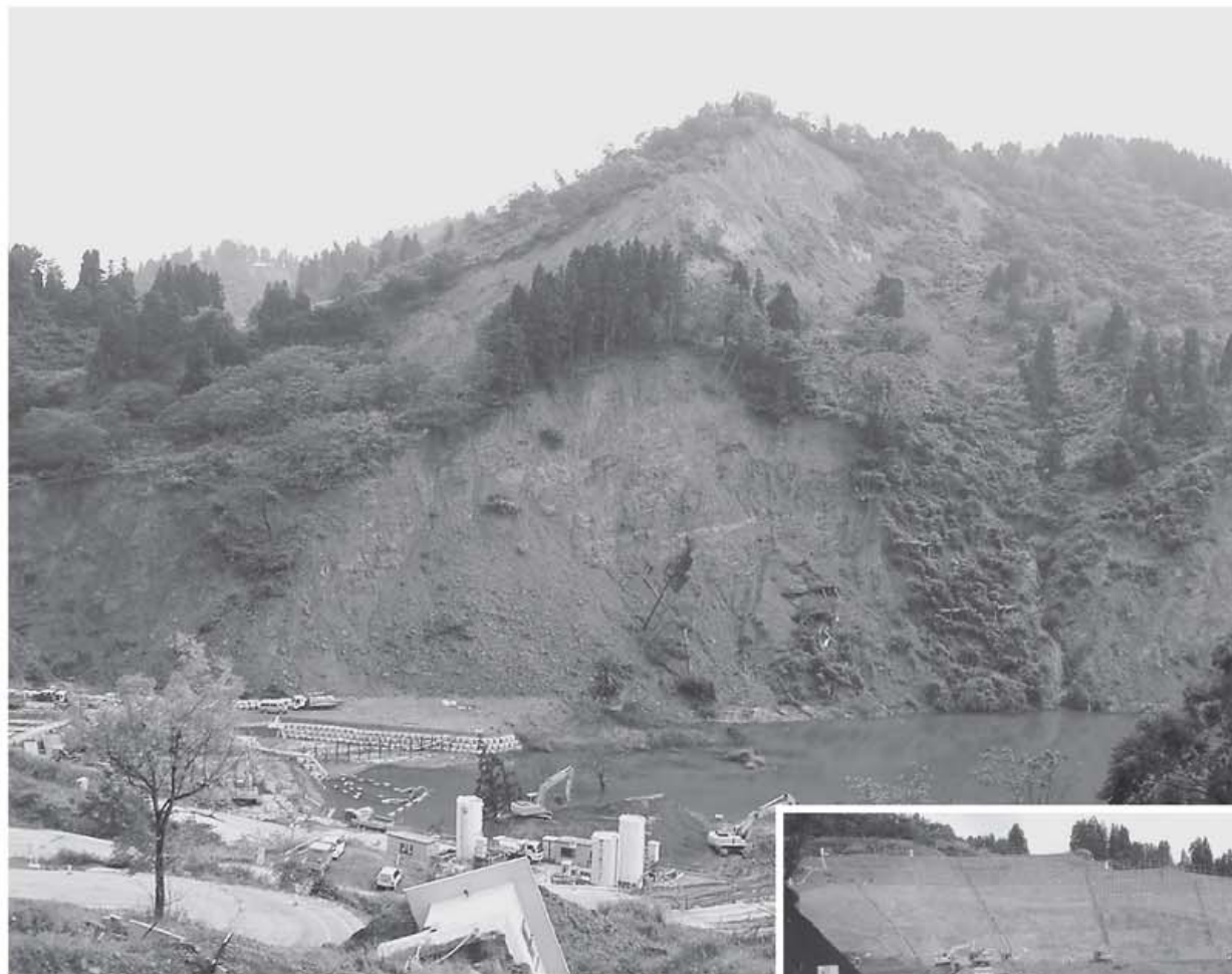
寺野の河道閉塞と復旧工事（平成17年10月16日撮影）
