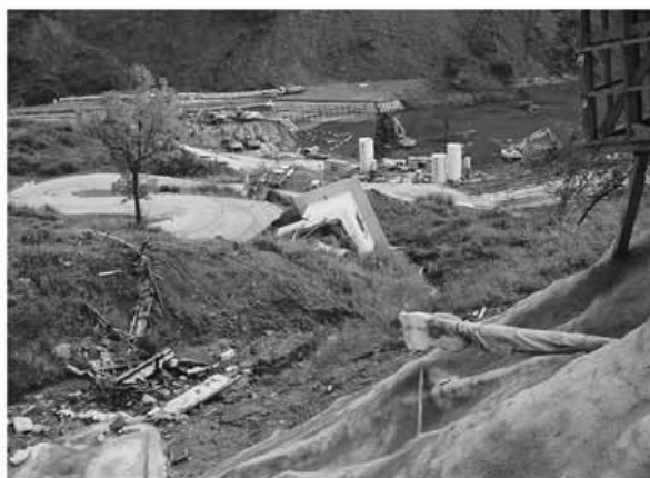
寺野の河道閉塞と簡易水道施設の損害
