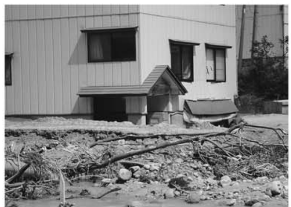
強震動で壊れ、河道閉塞で土砂に埋まった 榎ノ木集落センター（8月16日撮影）
