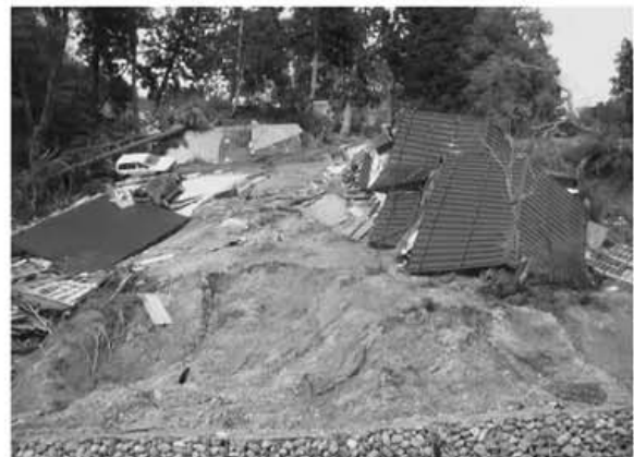
写真3 長岡市濁沢の地すべりによる家屋倒壊
