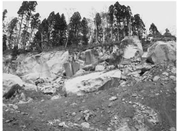
写真2 妙見の大規模岩盤崩落現場
