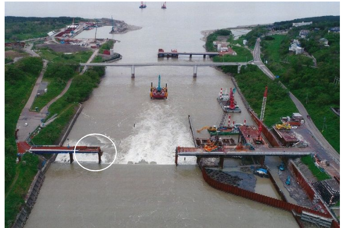
図2 新第二床固工の施工現場 (JV 荻野所長より)
