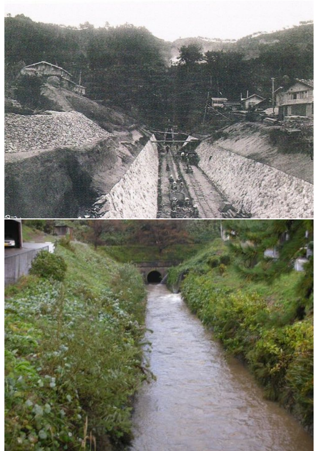
図14 円上寺隧道施工当時の吐口の様子と現在 (資料・写真等はいずれも新潟県長岡地域振興局提供のパンフレットより)
