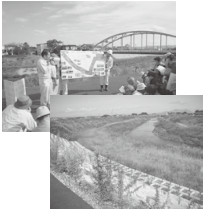
写真 1 刈谷田川破堤地点での説明と仮復旧護岸
