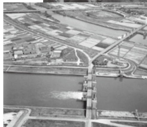
写真7 蒲原大堰と中之口水門
