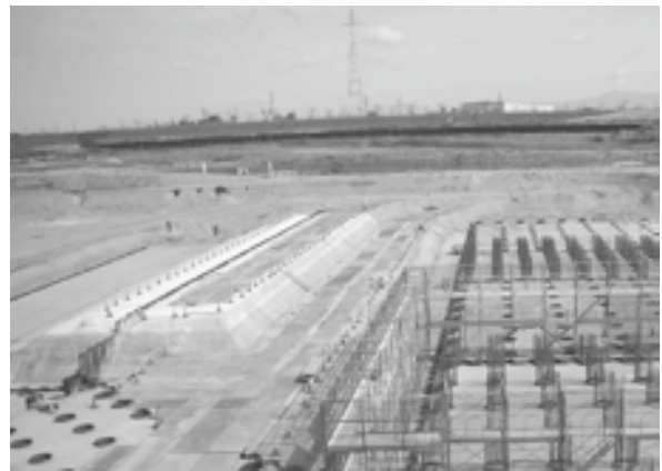
写真5 新可動堰の基礎工事
