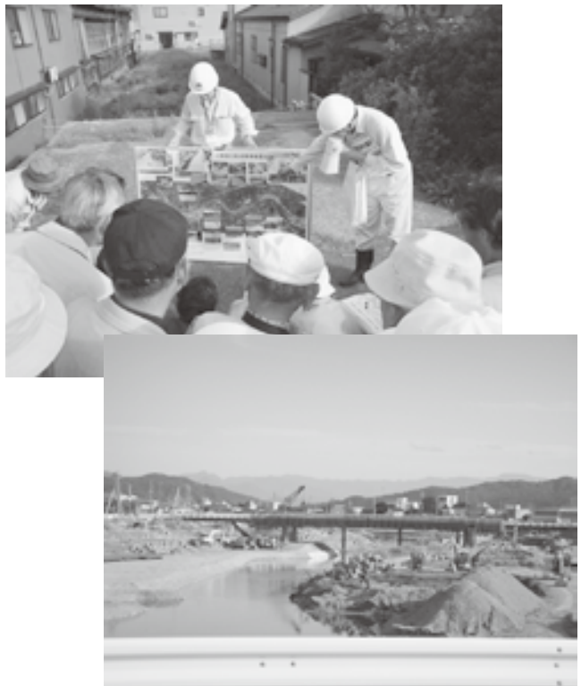
写真 2 五十嵐川災害復旧工事と事業説明の様子
