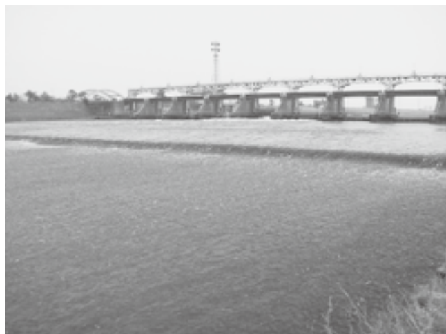
大河津分水可動堰（工事前）
