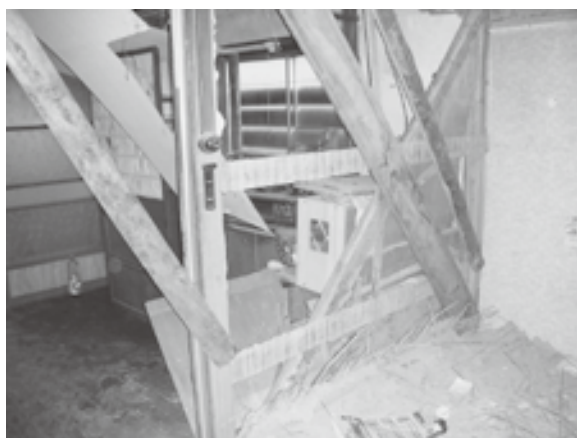
落ちた壁・応急の筋交い（椎谷）
