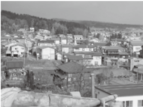
図8 岩田下 応急のブルーシート
