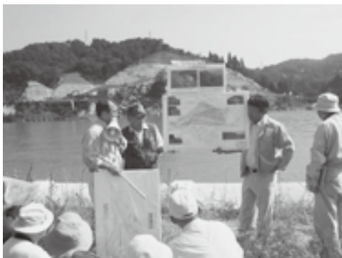
図5 対岸から妙見復旧工事現場
