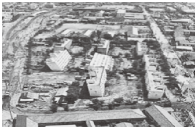
図3 県営アパートの液状化による被害
